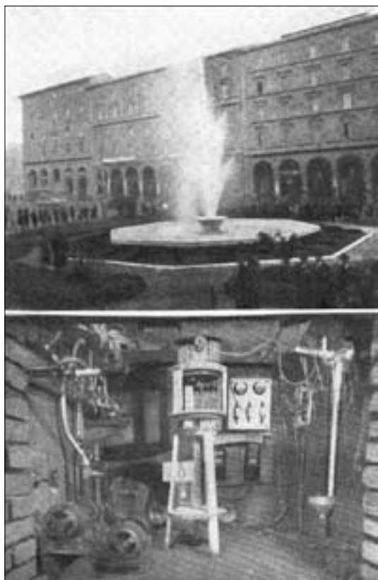
Fig. 1: La vecchia fontana con le cabine sottostanti (Ivo Luminasi, Bologna – Le grandi opere ferroviarie , Bologna 1927).
